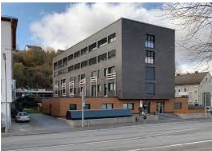
Abbildung 2: Altes Arbeitsamt Meschede nach dem Umbau (Foto: ZukunftBAU)
