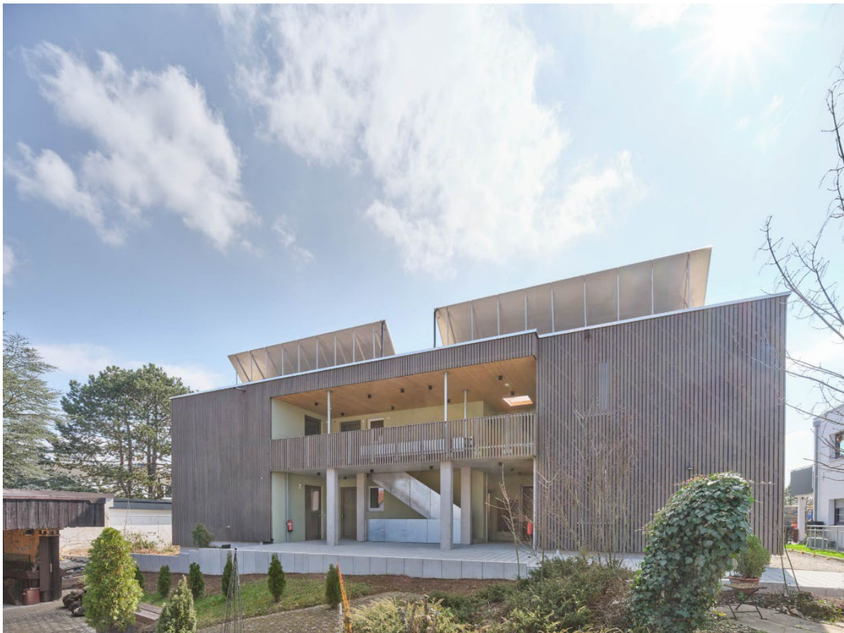
Abbildung 5: Gartenansicht "Pfrondorfer Neschtle" (buerohauser 2025) Quelle: https://buerohauser.com/projekt/wohnprojekt-in-holzbauweise-fuer-senioren/
