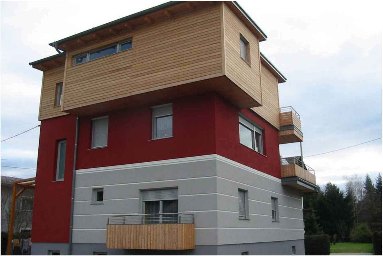
Abbildung 5: Aufstockung eines Einfamilienhauses mit Holz (Besser mit Holz, 2022, © Lappi & Lappi Holzbau)
