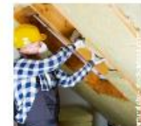
Oberer und unterer Gebäudeabschluss
