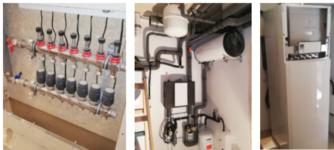
Abbildung 7: Anlagentechnik im Versorgungsherd
