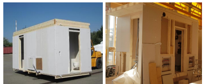
Abbildung 6: Serielle Vorfertigung des Versorgungsherzens
